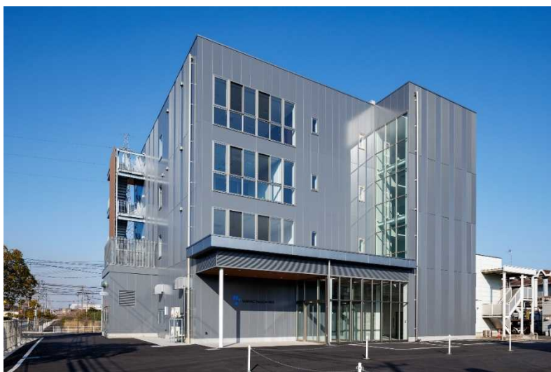
福山工場管理棟外観
